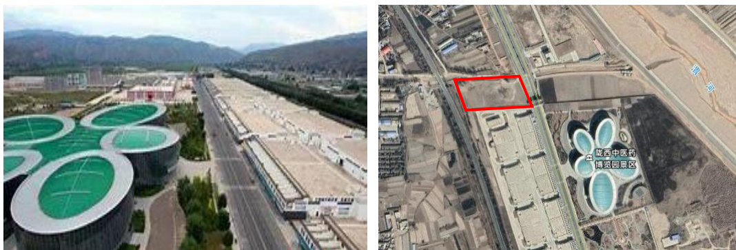
地块二 现状情况
