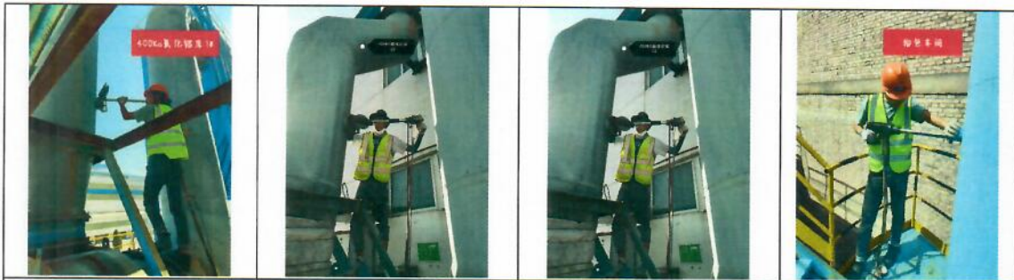
图 6-13 400KA 氧化铝 铝库 1#除尘器出口
